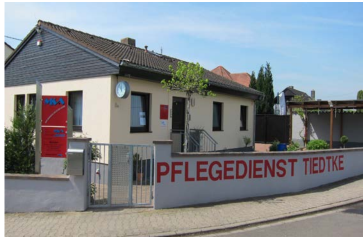
(Bürogebäude am Standort Monsheim)
